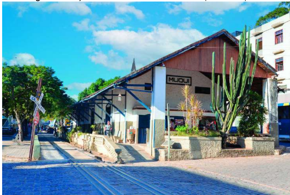
Figura 4. Estação Ferroviária tombada no Município de Muqui-ES.
